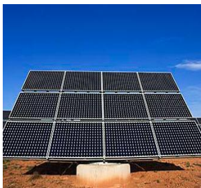
Wierzchosławice, kolektory słoneczne
